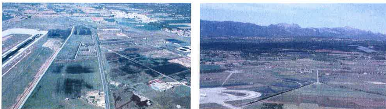
Figura 11. Imágenes de zonas inundadas cercanas a las pistas del aeropuerto de Son San Joan.
