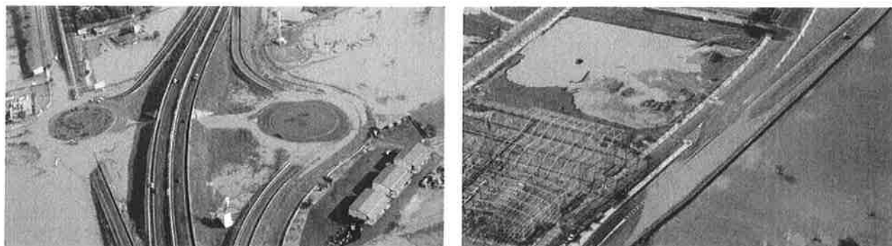
Figura 10. Tramos de la Autovía del Levante Ma-19 anegados por el agua.
