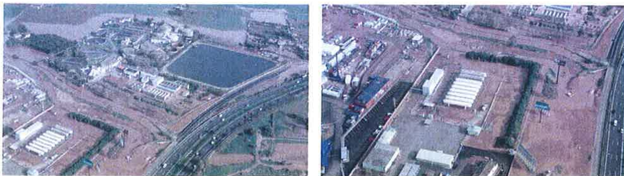
Figura 5. Imágenes de la central depuradora EDAR – Palma I y II, afectadas por inundaciones. Se aprecia la balsa donde se almacenan las aguas que usan los agricultores para regar sus cultivos.
